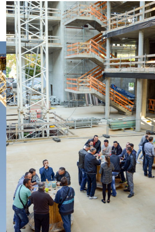
Im Rohbau: Richtfest 2015.
