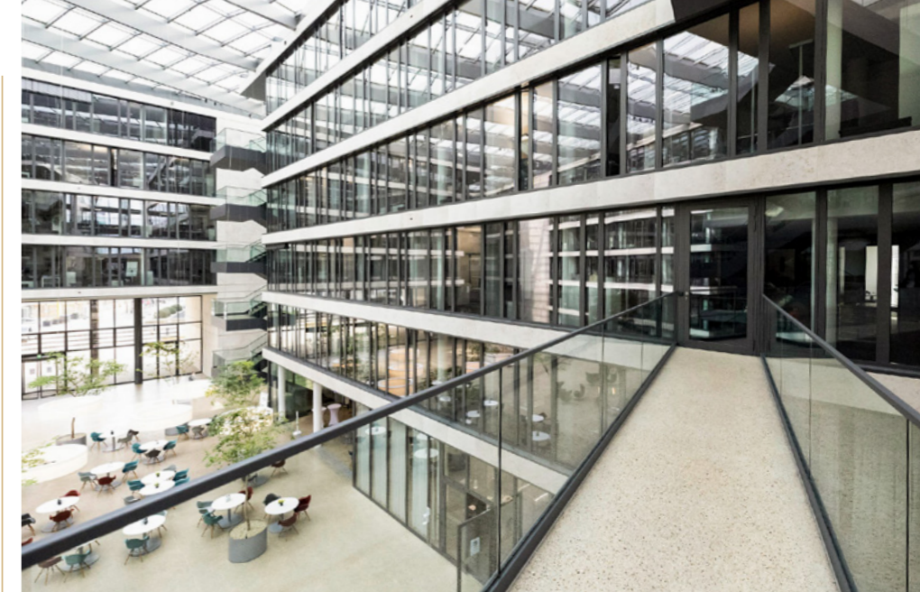
Die Gebäudeteile sind durch Brücken und Stege miteinander verbunden.
